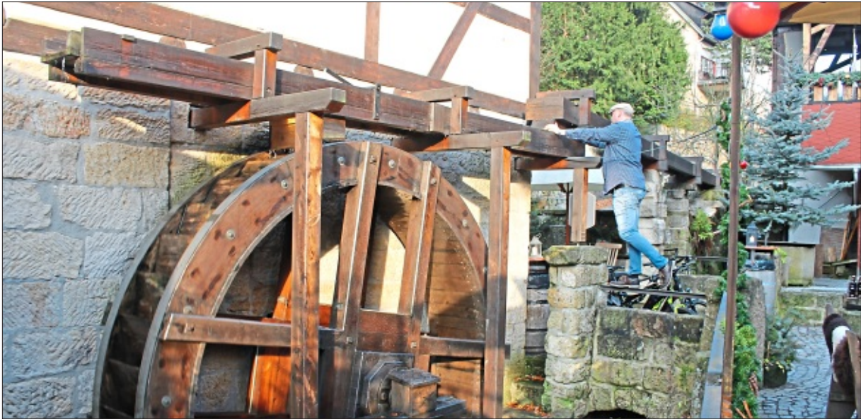
Handarbeit: Das alte Mühlenrad ließ Sven-Erik Hitzer nach alten Zeichnungen nachkonstruieren. Nun wird damit das Mehl für die Bio-Bäckerei nebenan gemahlen. – Fotos: Häusler
